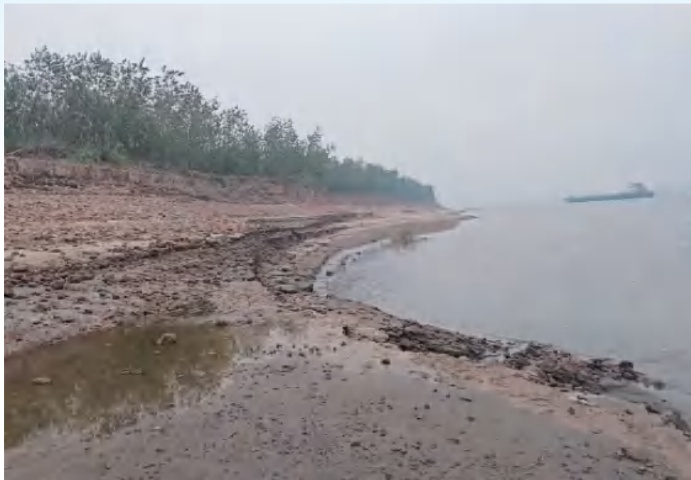
图 26 七弓岭河段七姓洲（15+550 ~ 15+580）崩岸
