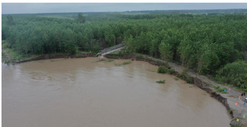
岳阳长江干堤荆江门桩号 4+060 ~ 4+185 堤段崩岸
