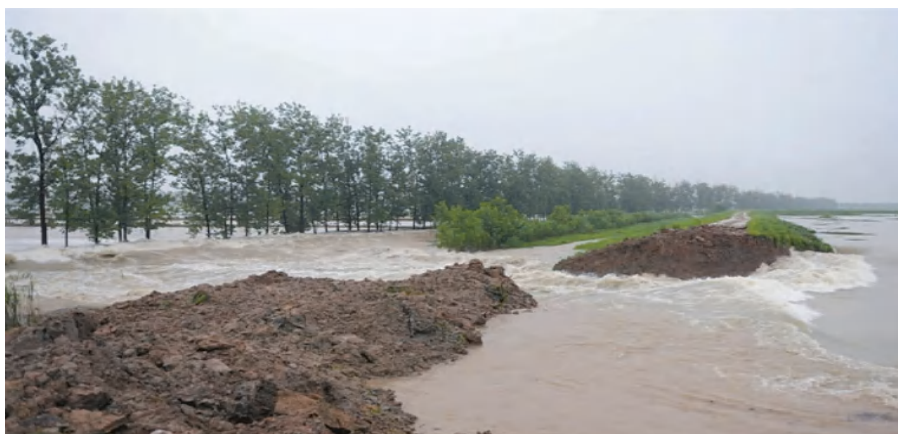
安徽省全椒县荒草三圩蓄滞洪区扒口分洪
