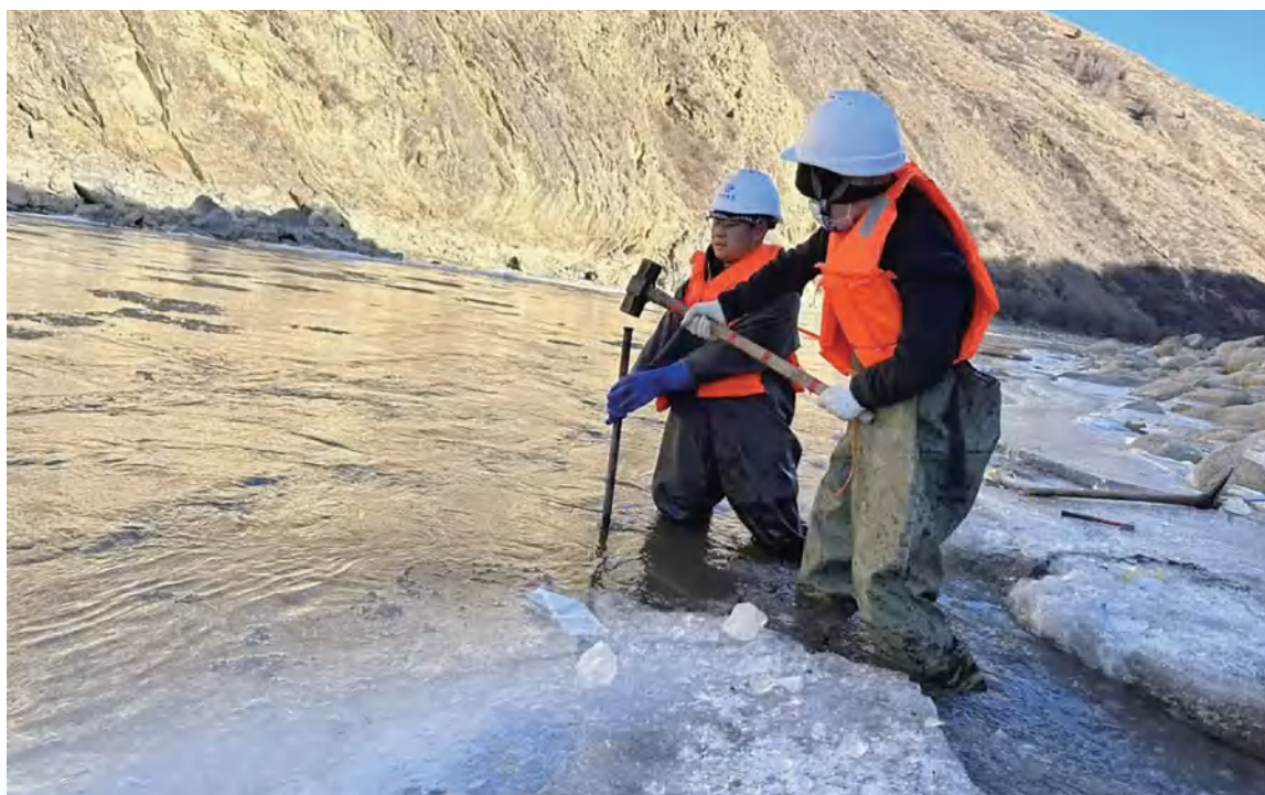
甘孜州炉霍水文站冰期埋设自记水位计气管
