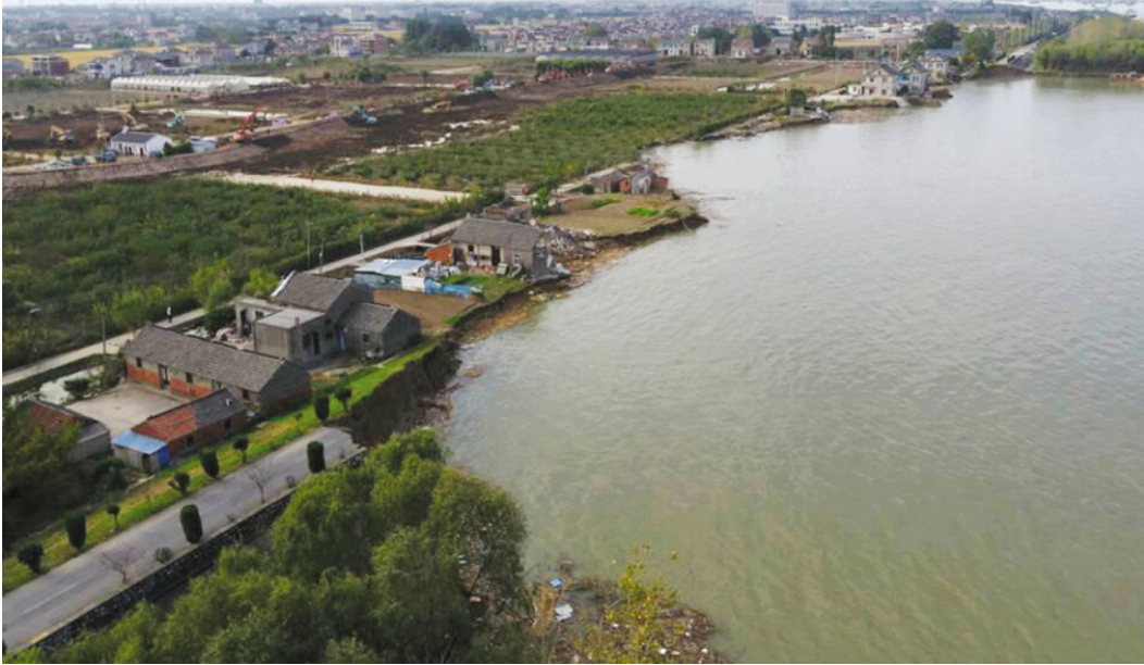
图 30 扬中市长江干堤三茅街道指南村段崩岸
