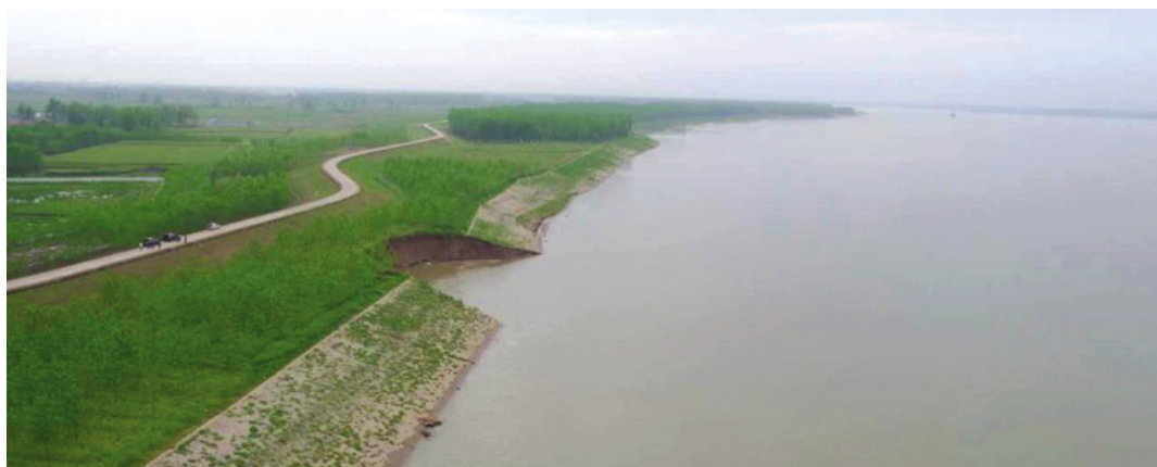
图 29 洪湖长江干堤燕窝虾子沟崩岸
