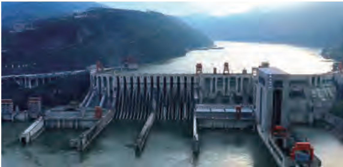
向家坝水电站
