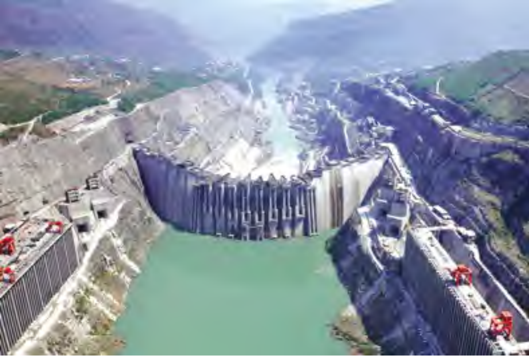
溪洛渡水电站
