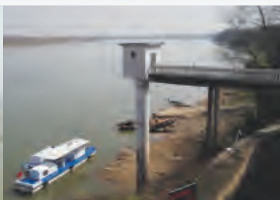
信江梅港站水位观测平台
