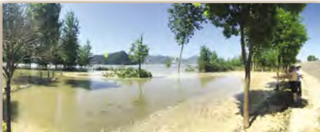
图 26 黄冈茅山堤团林段桩号 148+850~148+950 崩岸
