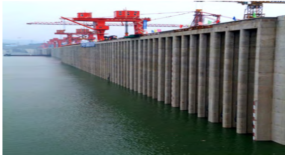
三峡水库 156 米水位坝前情景
