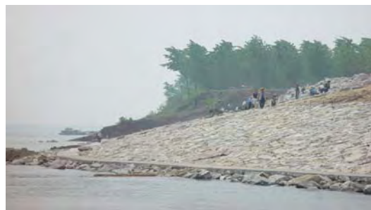
天字一号护坡
