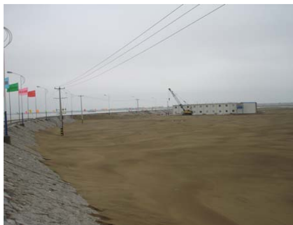
长江下游海门市新通海沙下段岸线综合整治工程采砂吹填区
