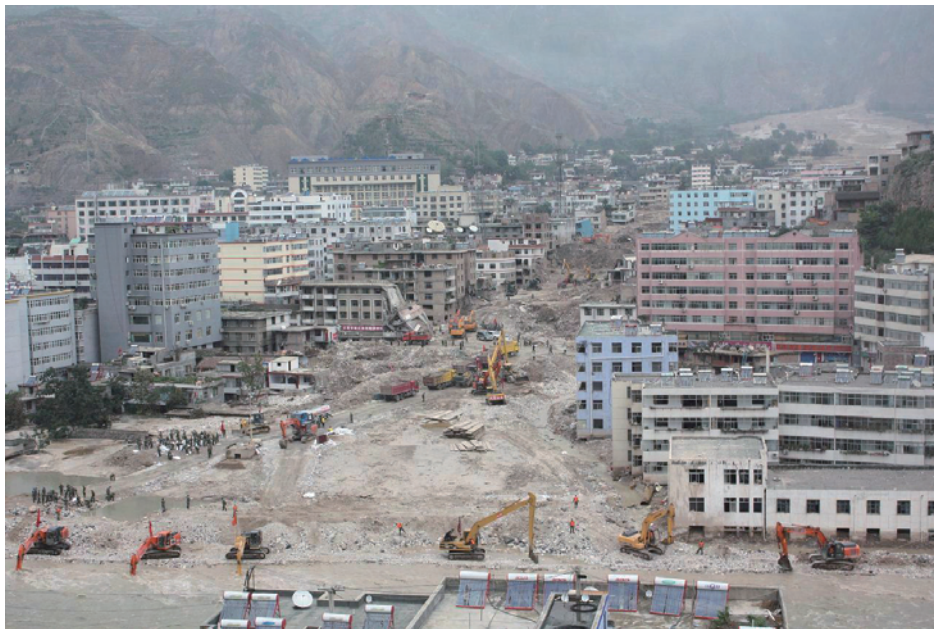
舟曲泥石流清淤现场
