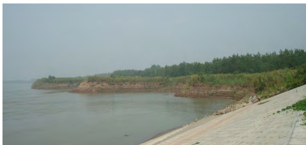
图 21 下荆江铺子湾段崩岸险情(桩号 16+220~17+310)
