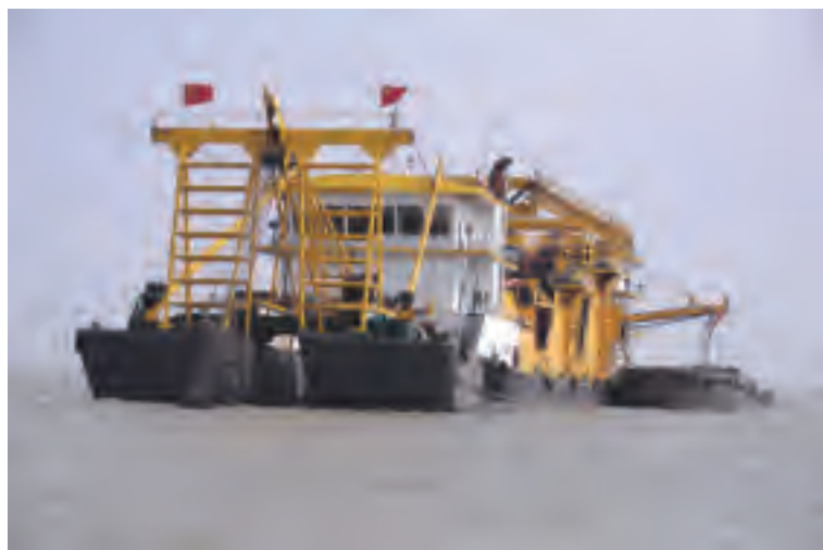
图 25 安徽省枞阳县永登圩可采区采砂作业现场
