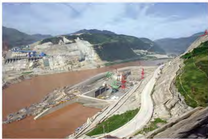
向家坝水电站截流
