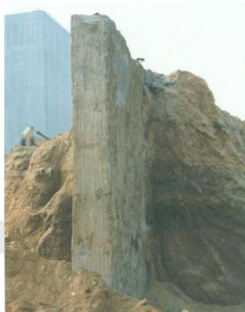
三峡二期围堰塑性混凝土防渗墙
