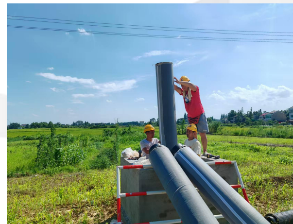
减压井滤芯安装
