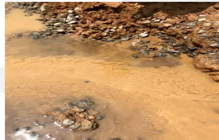
江西彭泽花亭堤管涌险情 (2020)
