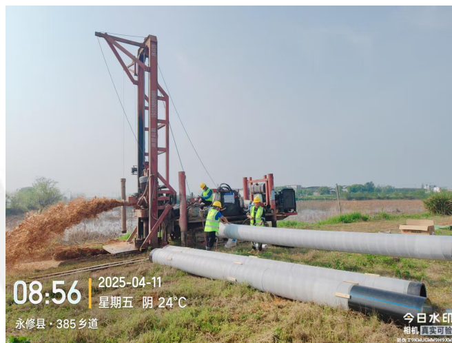
永修县九合联圩减压井施工
