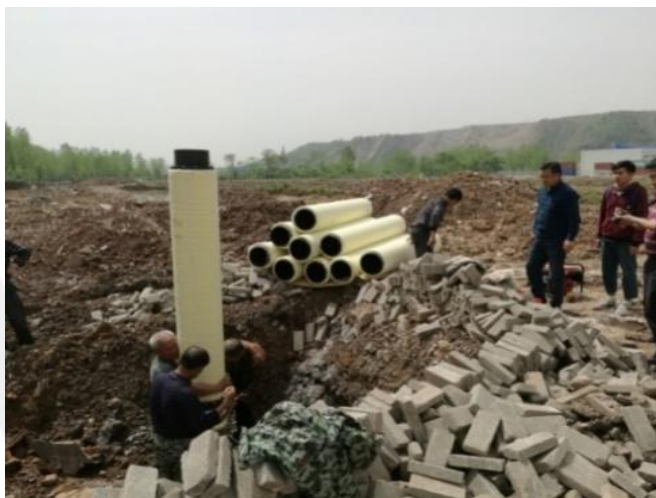
阳新长江干堤减压井施工现场
