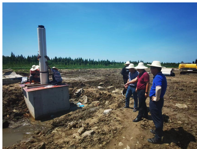
汉江遥堤减压井施工现场
