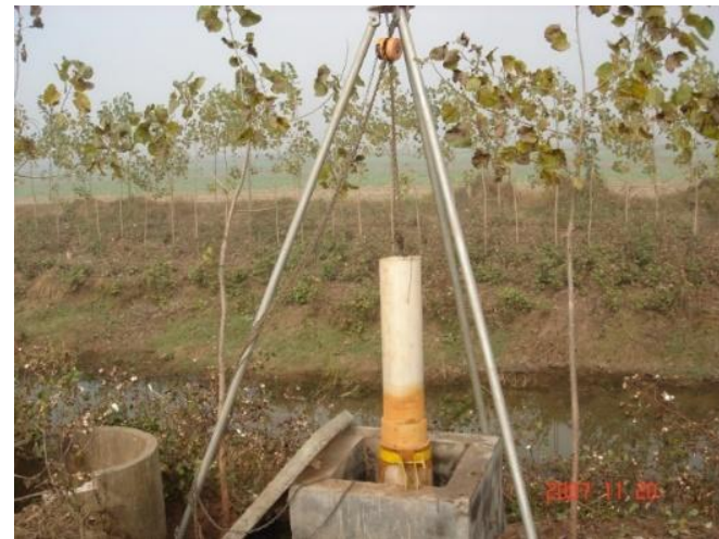
减压井滤芯拔出维护 (2007年荆州)
