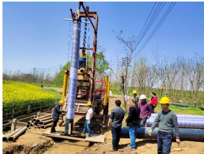
九江长江干堤减压井施工现场
