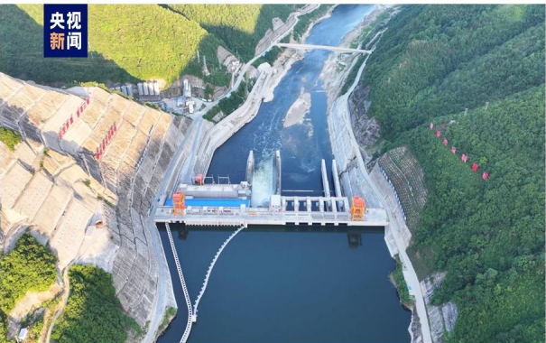
引汉济渭工程
